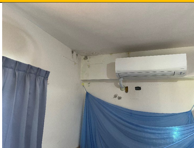
防水工程(天花板)
